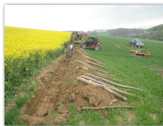
► La fascine est constituée de 2 rangées de pieux de saule remplis de fagots.
