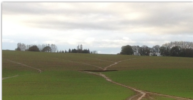
► La fascine a été placée perpendiculairement à l'axe de ruissellement afin de ralentir l'écoulement de l'eau et de retenir la terre.
