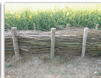
► La fascine est constituée de 2 rangées de pieux de saule remplis de fagots.
